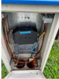
Slika 16 i 17: Glavni razdjelnik u POP3 ormaru i primjer izvodnog ormara
