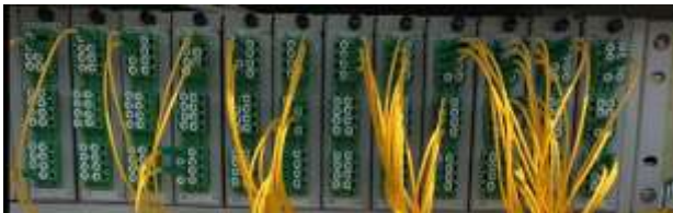
Slika 7: Optički razdjelnik sa 288 LC/APC adaptera
