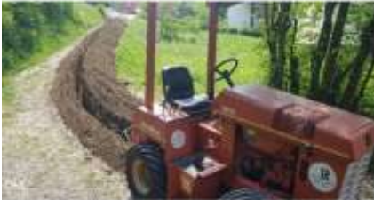
Slike 2 i 3: Mašinski i ručni iskop rova
